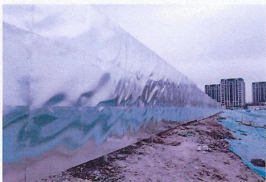
项目西侧围挡
