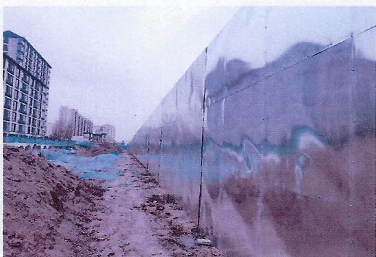
项目北侧围挡
