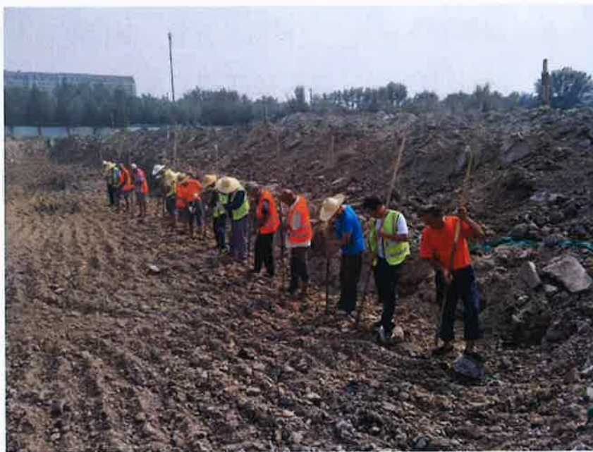
图七 勘探现场工作情况
