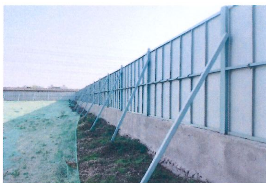
项目西侧围挡
