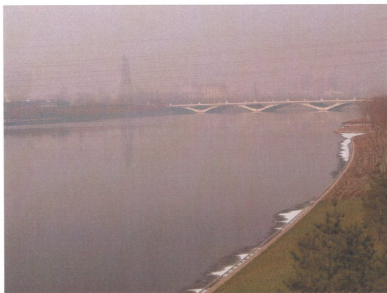
图 2-2 建设用地西侧的北运河
